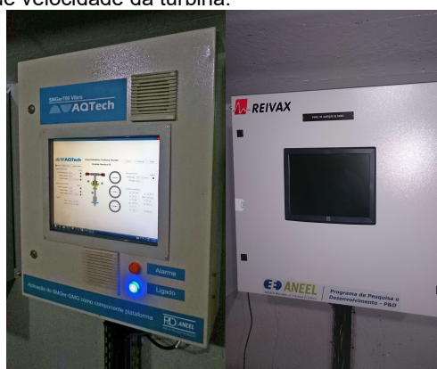
FIGURA 3 - Esquerda: painel de detecção de vibração. Direita: painel de monitoramento de cavitação.
