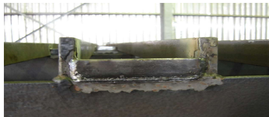
Figura 5 - Reforço soldado no painel de grade da tomada d'água da UHEGJR
