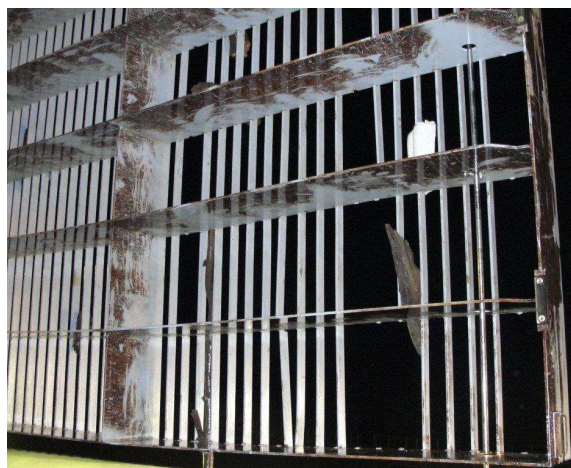
Figura 7 - Painel de grade Geração 03 (com avarias após evento de 2014)
