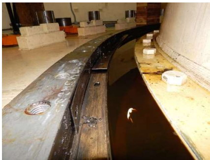
Figura 9 – Avarias encontradas no mancal axial inferior e mancal radial do anel de regulação.
