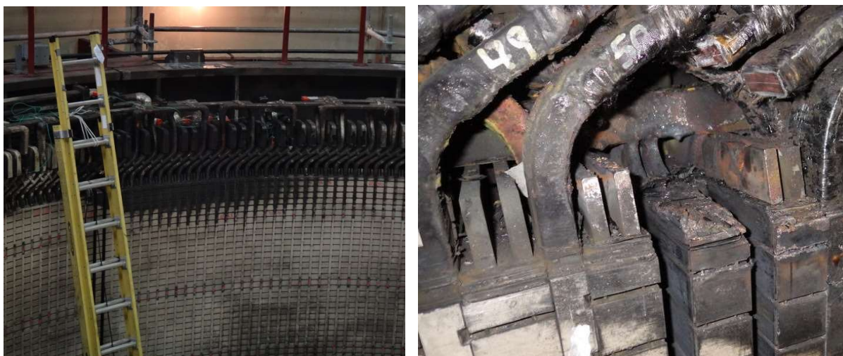
Figura 5 – Núcleo do estator: Inspeção visual e danos ao primeiro pacote
