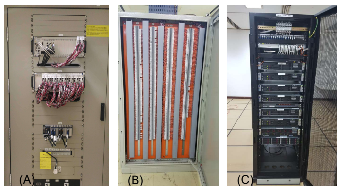
FIGURA 2 – (A) Pannel frontal de uma UAM contendo o hardware modular de aquisição e processamento. (B) Pannel traseiro de uma UAM contendo as conexões dos sinais dos sensores. (C) Servidores e Storage.
