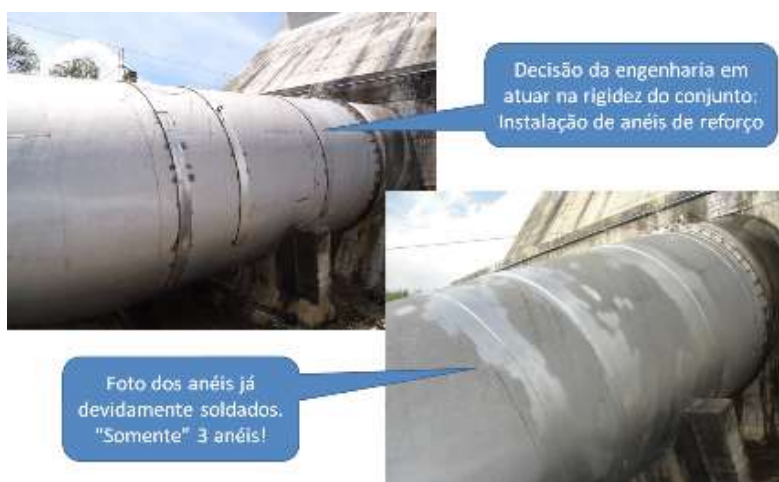
FIGURA 10 – Montagem dos anéis no conduto forçado
