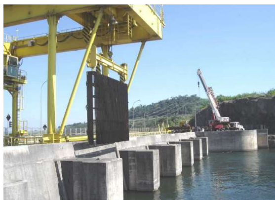
Figura 3 - Retirada de painel para inspeção a seco
