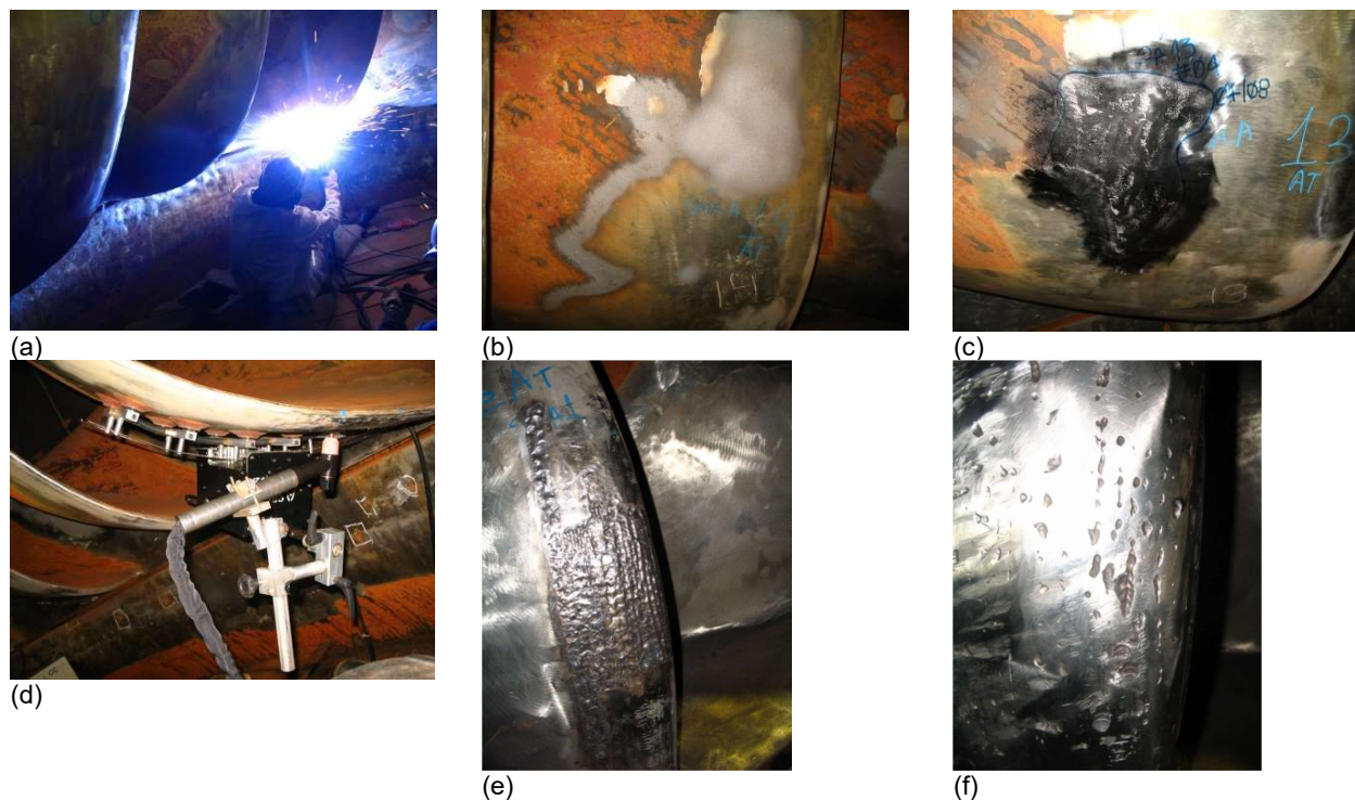
FIGURA 7 – Deposição de revestimentos por aspersão térmica ASP em pás de rotor de aço carbono da Usina Hidrelétrica GBM Resultado de PeD ANEEL (5). (a) operação de deposição, (b) regiões com jateamento e deposição de revestimentos, (c) região com revestimentos polido, (d) equipamento posicionado para refusão do revestimento por soldagem plasma PAW, (e) revestimento refundido e (f) revestimento refundido polido.
